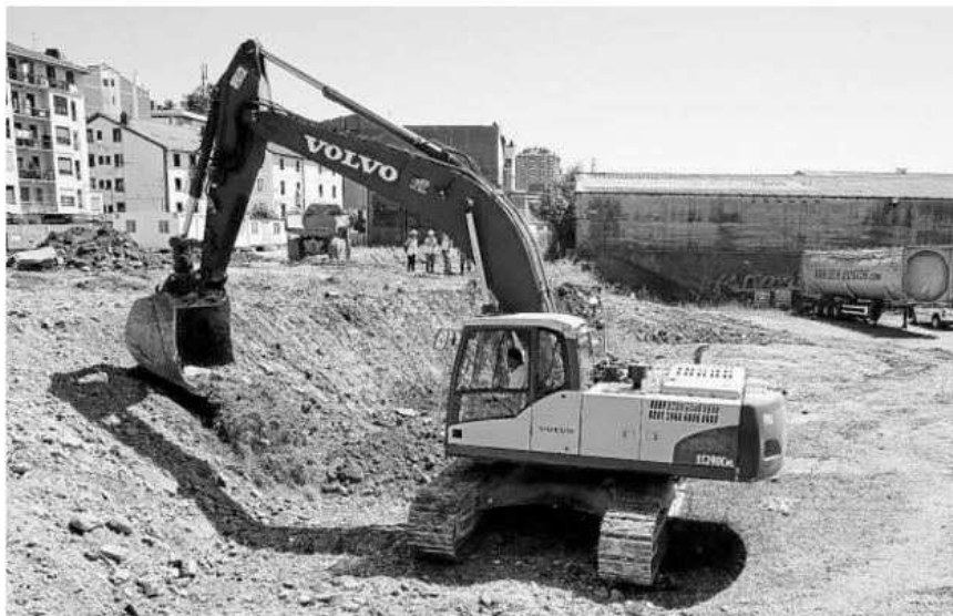
Una de las máquinas que ya se encontraba ayer trabajando en la zona.
